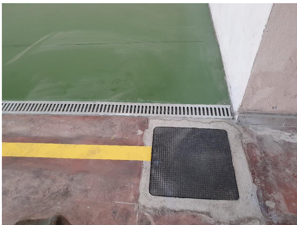
Ilustración 2. Detalle de la recogida de escurridos
